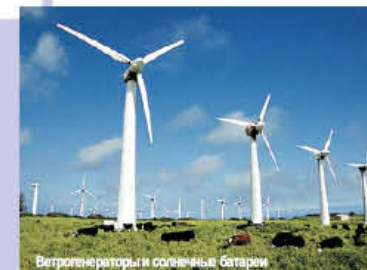
Ветрогенераторы и солнечные батареи
